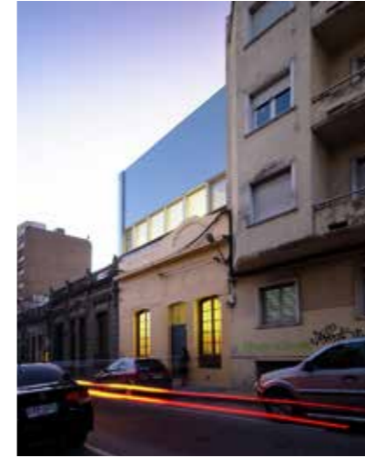
Urban House, FGM Arquitectos
